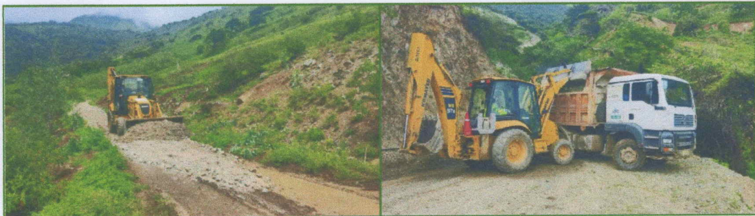
Imagen 06: Observación en campo de los trabajos del mantenimiento de la vialidad parroquial.
