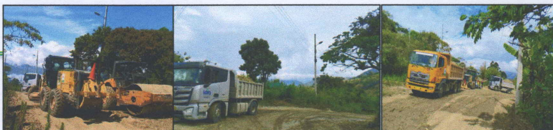
Imagen 03: Coordinación de mantenimiento en la vialidad en convenio con la Prefectura de Loja.
